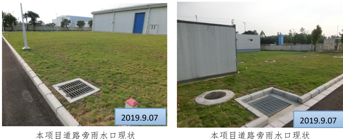
图 3-1 水土保持工程措施照片
